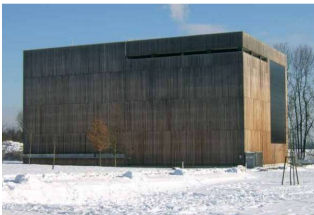
Holzheizkraftwerk Scharnhäuser Park (DE) ORC + Gas boilers
